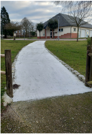
Chemin piétonnier Travaux 2024
