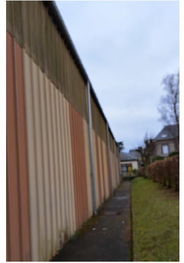
Gouttières de la Salle des Sports Travaux janvier 2025
