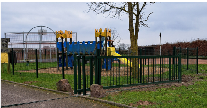
Clôture du parc de jeux et barrière de la salle polyvalente Travaux 2024
