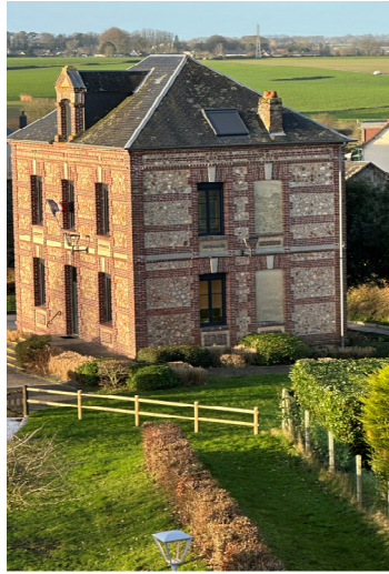
Fenêtres de la mairie Travaux 2024
