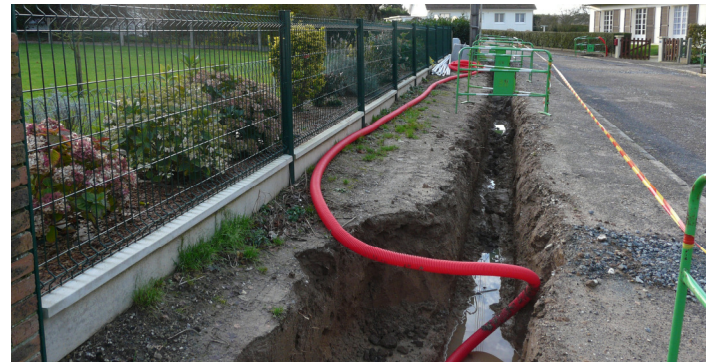
Enfouissement des réseaux - Rue des Hortensias Travaux 2024
