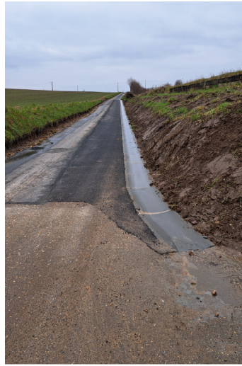
Fond d'Ygneauville Travaux de l'Agglo - Janvier 2025
